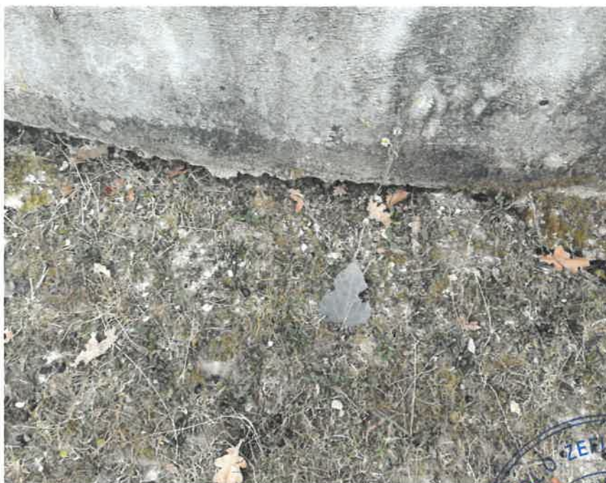
Foto 14 Tasări diferite ale fundațiilor
