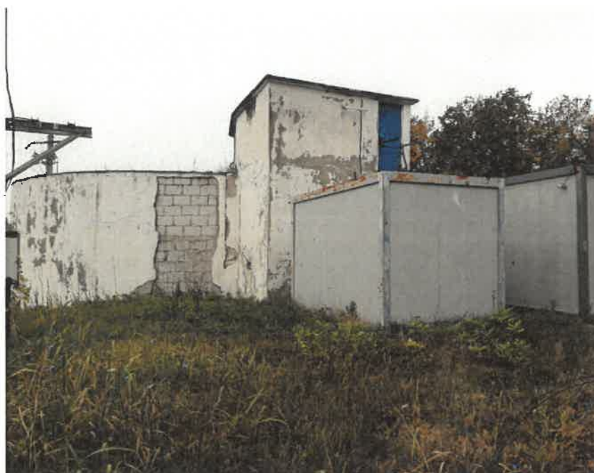
Foto 16 Tencuieli exterioare desprinse
