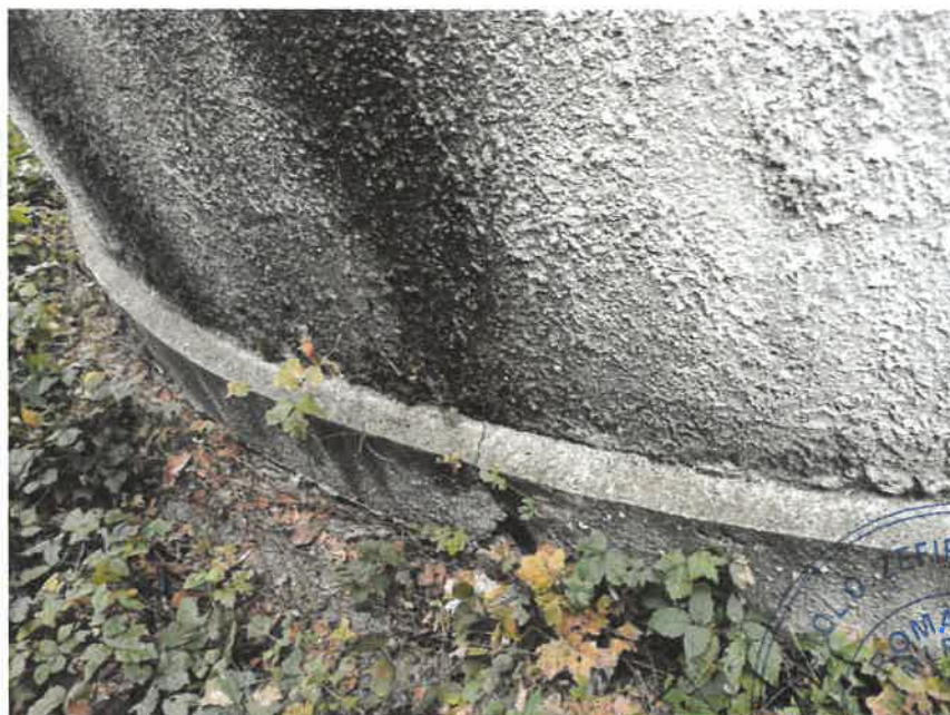
Foto 6 Fisuri la nivelul soclului
