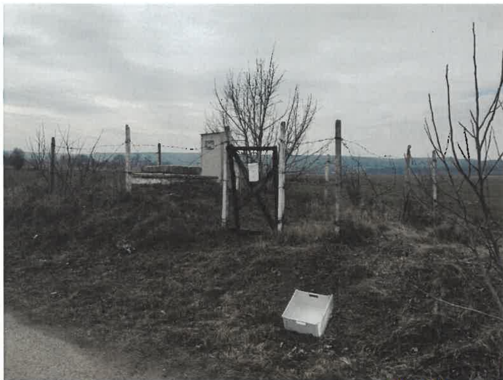
Foto 16 Capac improvizat pentru camera puturilor
