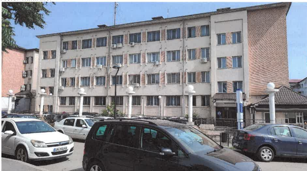
Foto – sediul I.P.J. Vrancea existent: vedere exterioara acces principal
