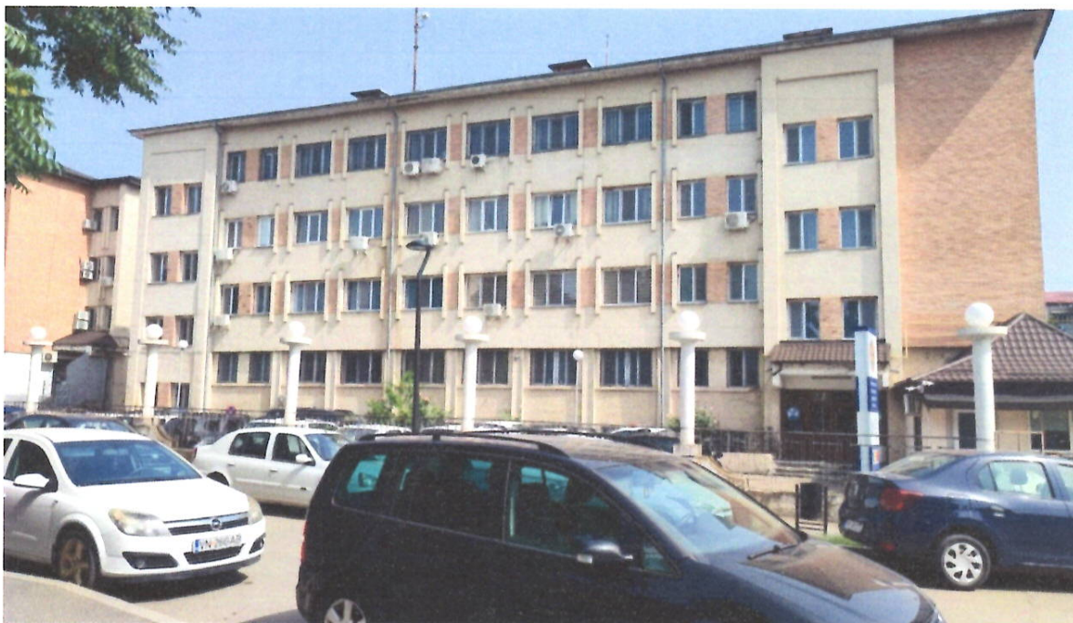
Fațadă principală Corp C7
