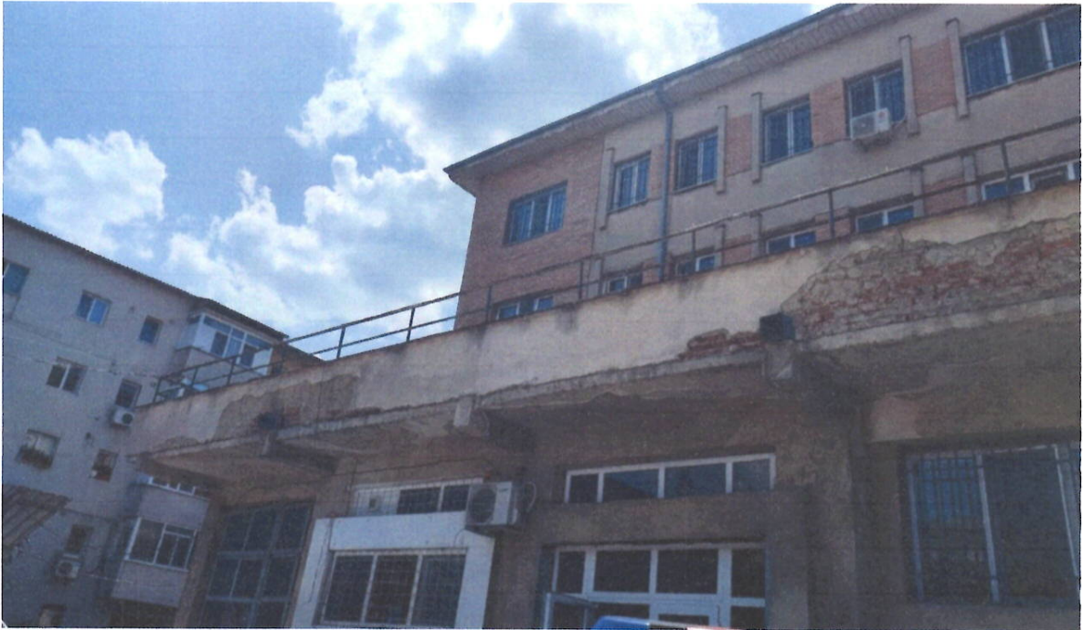
Fațadă posterioară Corp C6 și Corp C7: tencuială degradată la atic și la intrados planșeu peste parter
