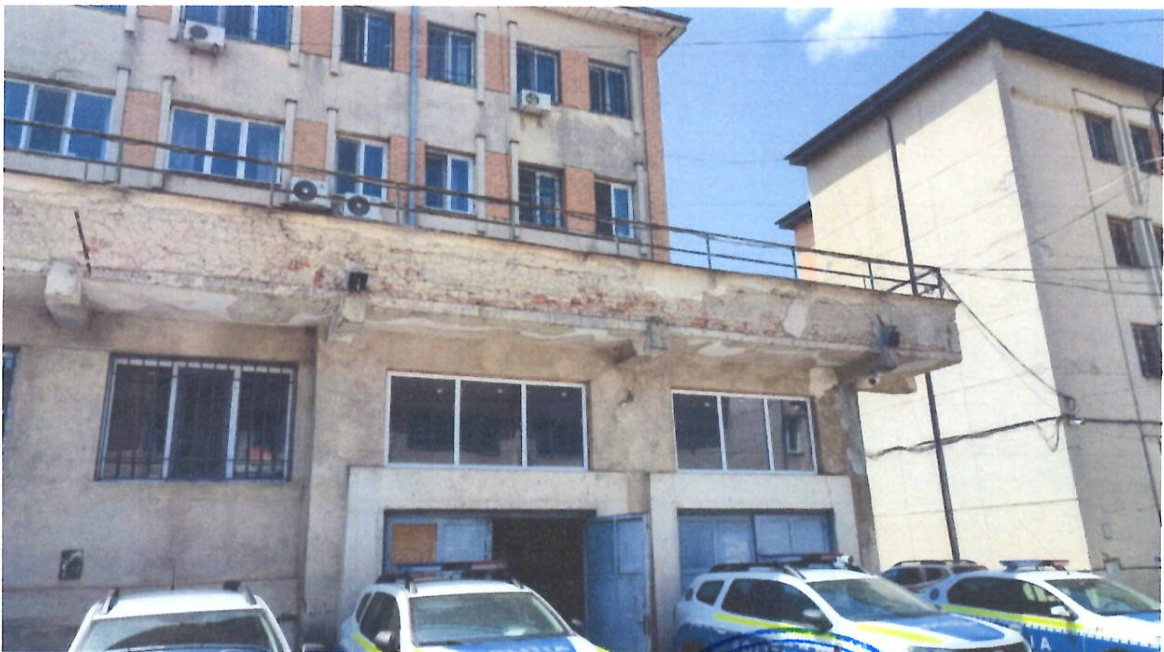
Fațadă posterioară Corp C6 și Corp C7: tencuială degradată la atic și la intrados planșeu peste parter
