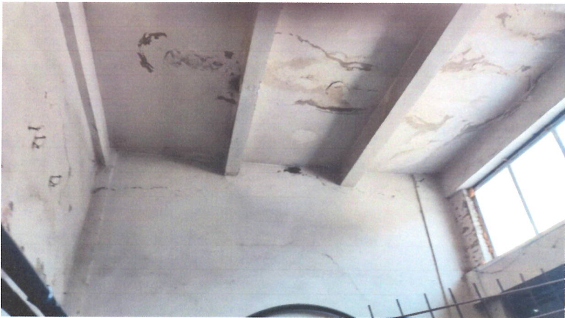
Corp C6: finisaje la tavan degradate (zugrăveala și tencuiala exfoliate) din cauza infiltrațiilor de pe terasă
