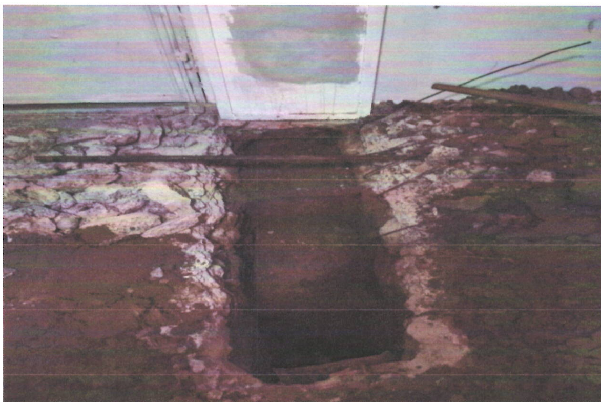
Foto 1. Dezvelire de fundație S1, corp C6- Inspectoratului Județean de Poliție Vrancea, Municipiul Focșani, județul Vrancea, NC-51633, strada Cezar Bolliac, nr.12.
