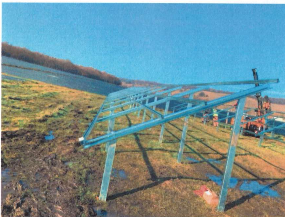
Exemplu de structura metalica pe sol
