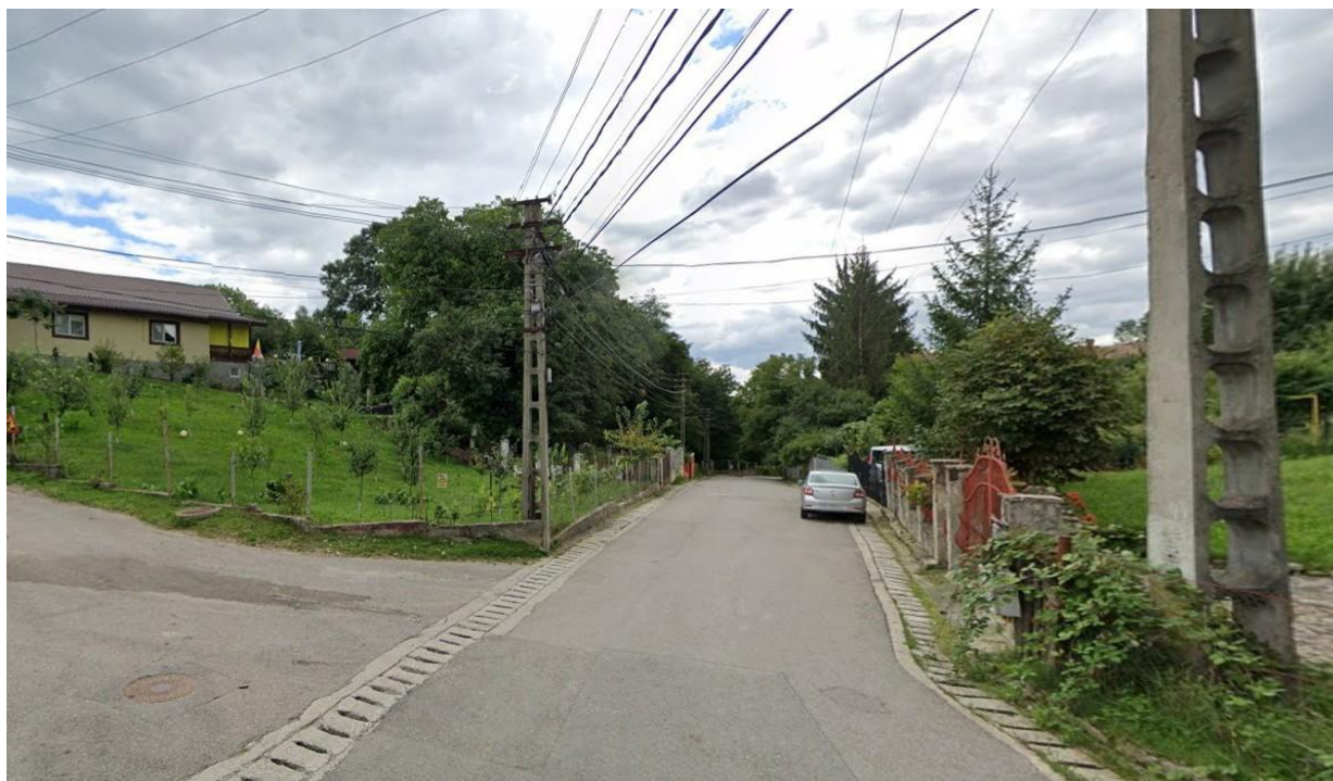
Figura 49 – Propunere Locația 44 – 1 Cameră fixă
