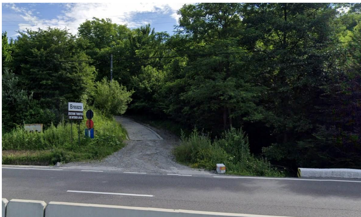
Figura 35 – Propunere Locația 30 – 1 Cameră fixă
