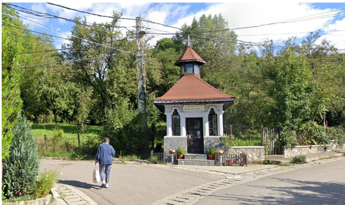
Figura 40 – Propunere Locația 35 – 1 Cameră fixă
