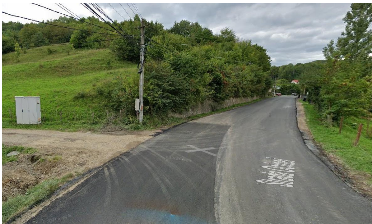
Figura 23 – Propunere Locația 18 – 1 Cameră fixă
