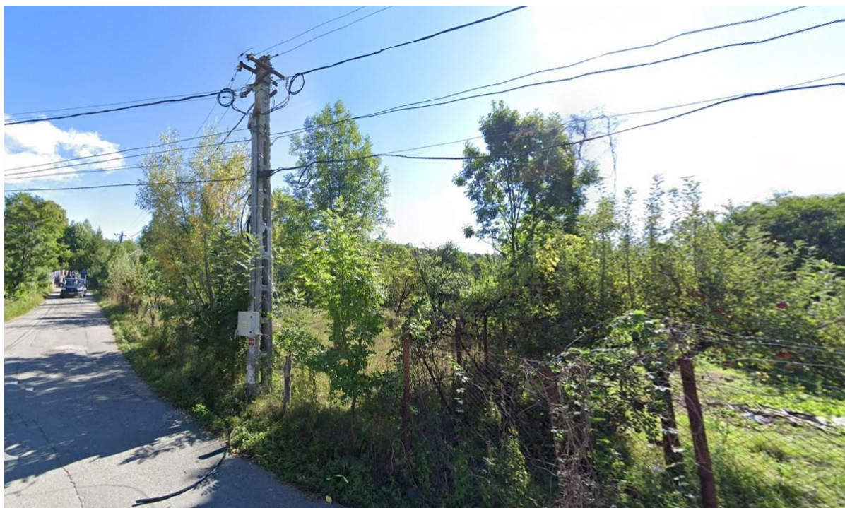
Figura 33 – Propunere Locația 28 – 1 Cameră fixă
