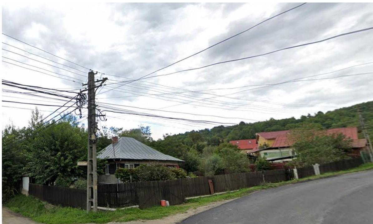
Figura 25 – Propunere Locația 20 – 1 Cameră fixă
