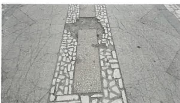
Zona pietonală - pardoseală
