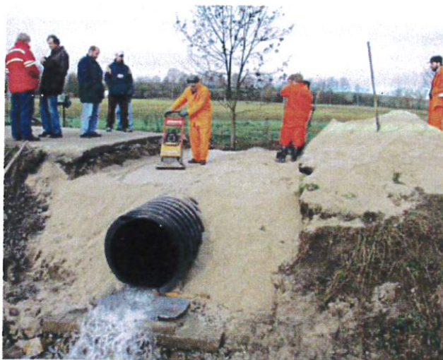
Figura 5. Compactarea materialului de rambleu deasupra conductei
