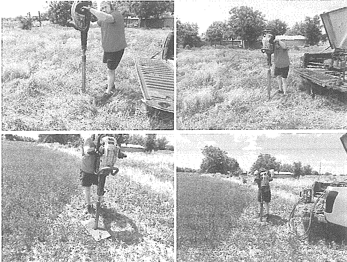
Figura 12. Realizare foraje geotehnice
