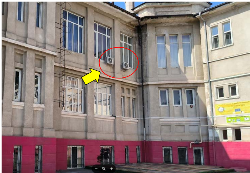
Figura 13 Aparate SPLIT pe fatada principala a cladirii
