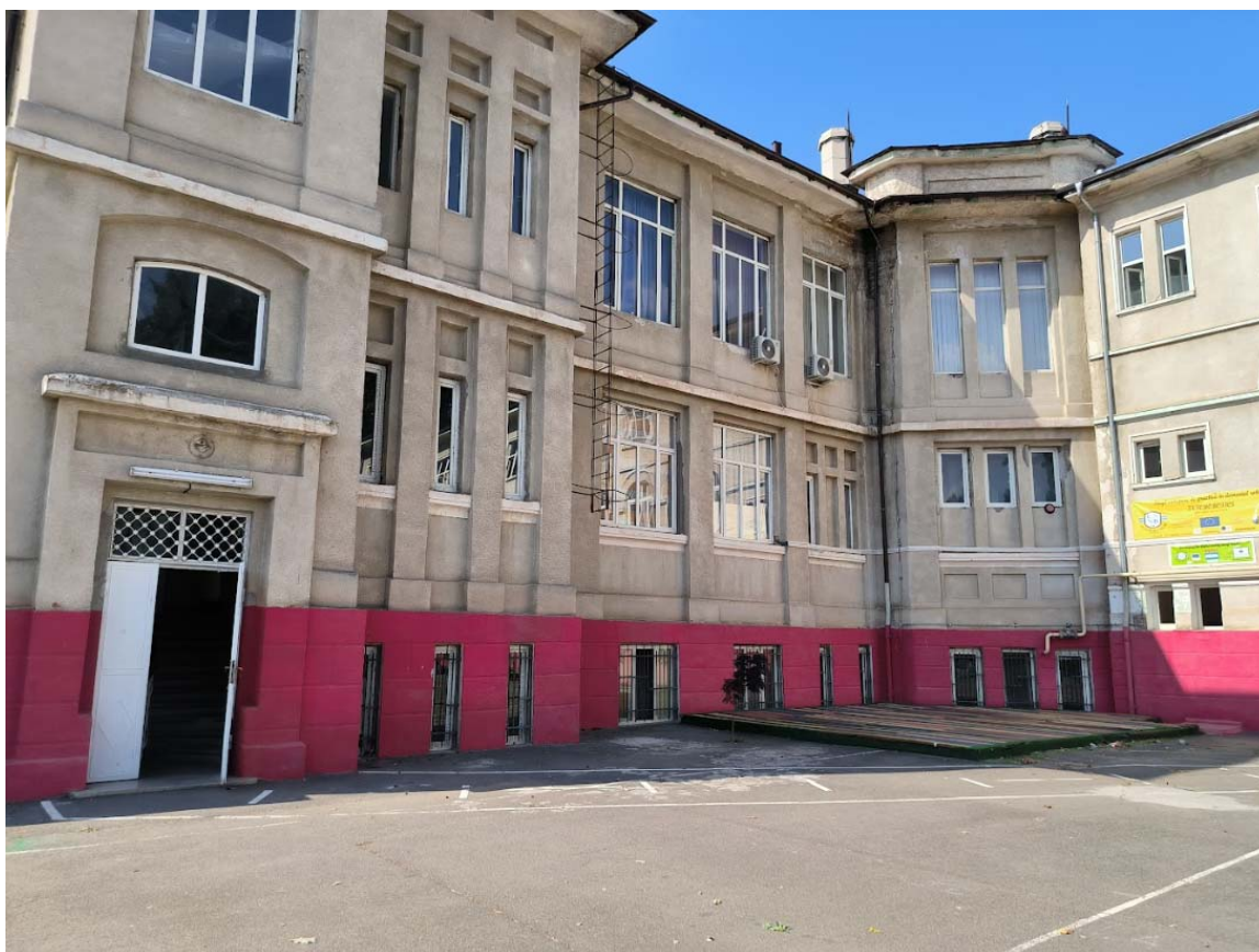
Figura 1 Fațadă principală clădire
