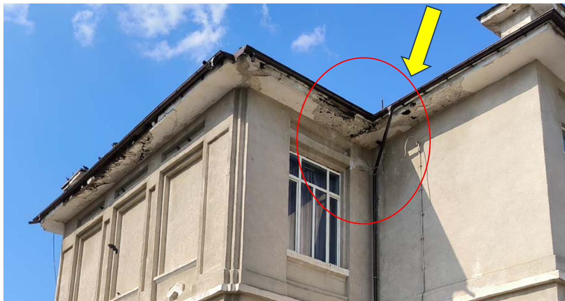
Figura 5 Uzura și decolorarea finisajelor exterioare
