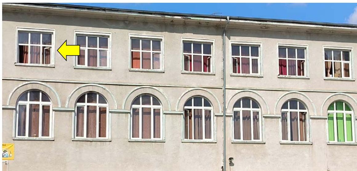
Figura 14 Protectii solare improvizate la nivelul sticlei interioare
