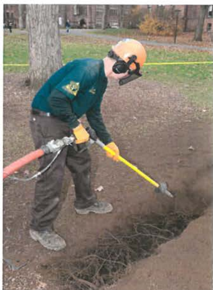
Fig. 7 - Exemplificare referitoare la utilizarea sistemelor de tip AirSpade pentru intervenții în Zona de Protecție a Arborelui (ZPA) pe parcursul lucrărilor de amenajare: (stânga) excavarea sistemului radicular fără afectarea rădăcinilor arborelui prin rupere sau tăiere; (dreapta) acoperirea rădăcinilor după finalizarea intervențiilor punctuale
