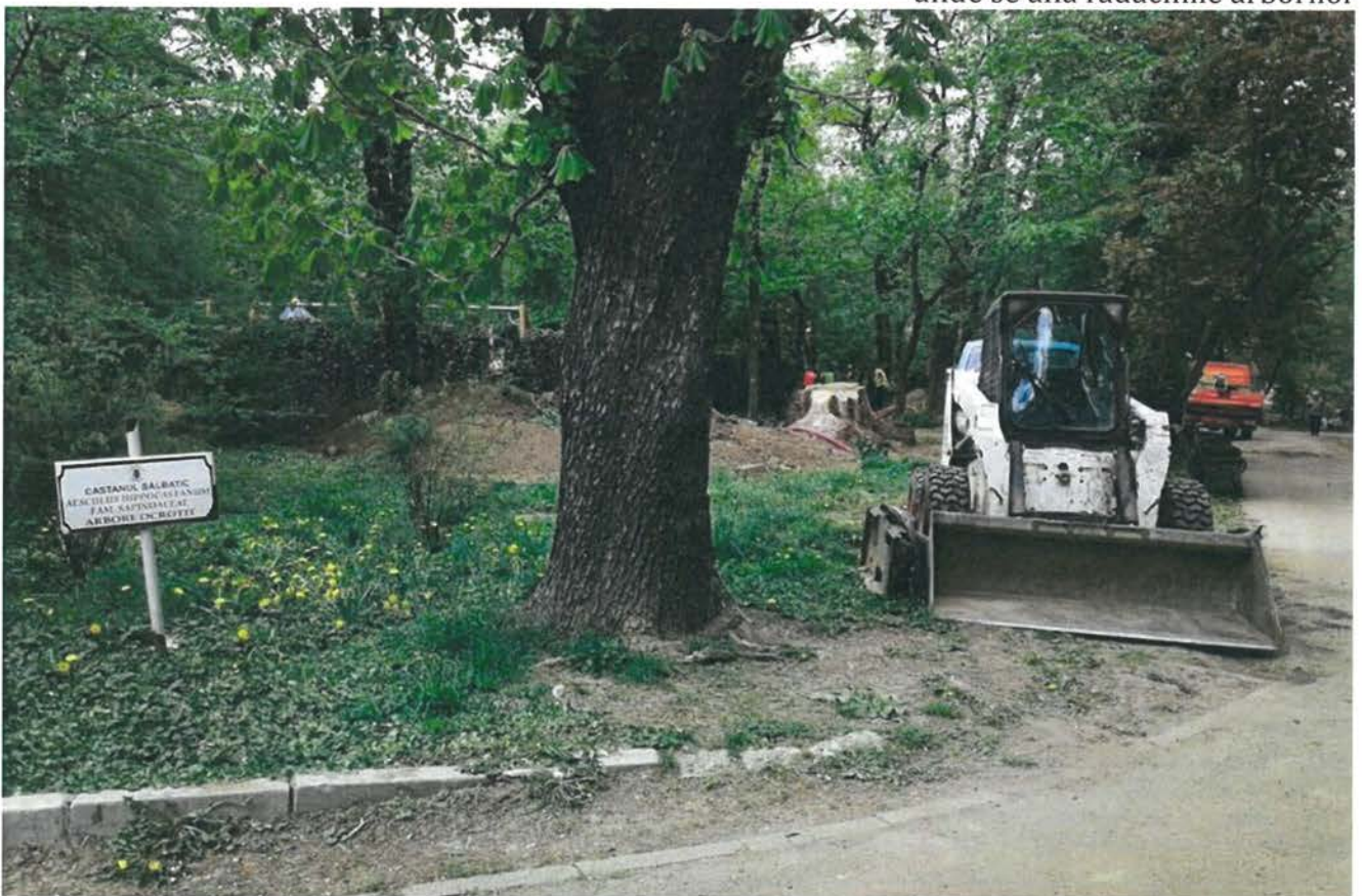
Fig. 3 - Exemplu referitor la tasarea solului prin depozitarea echipamentelor de lucru pe rădăcinile arborilor
