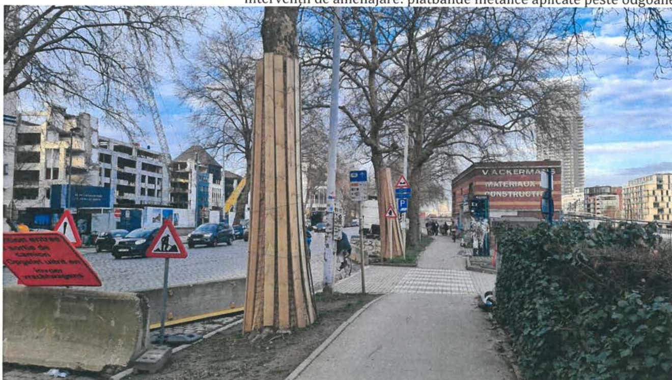
Fig. 9 - Exemplu referitor la protejarea trunchiurilor arborilor existenți pe parcursul realizării unor intervenții de amenajare: stinghii de lemn peste rogojină de papură
