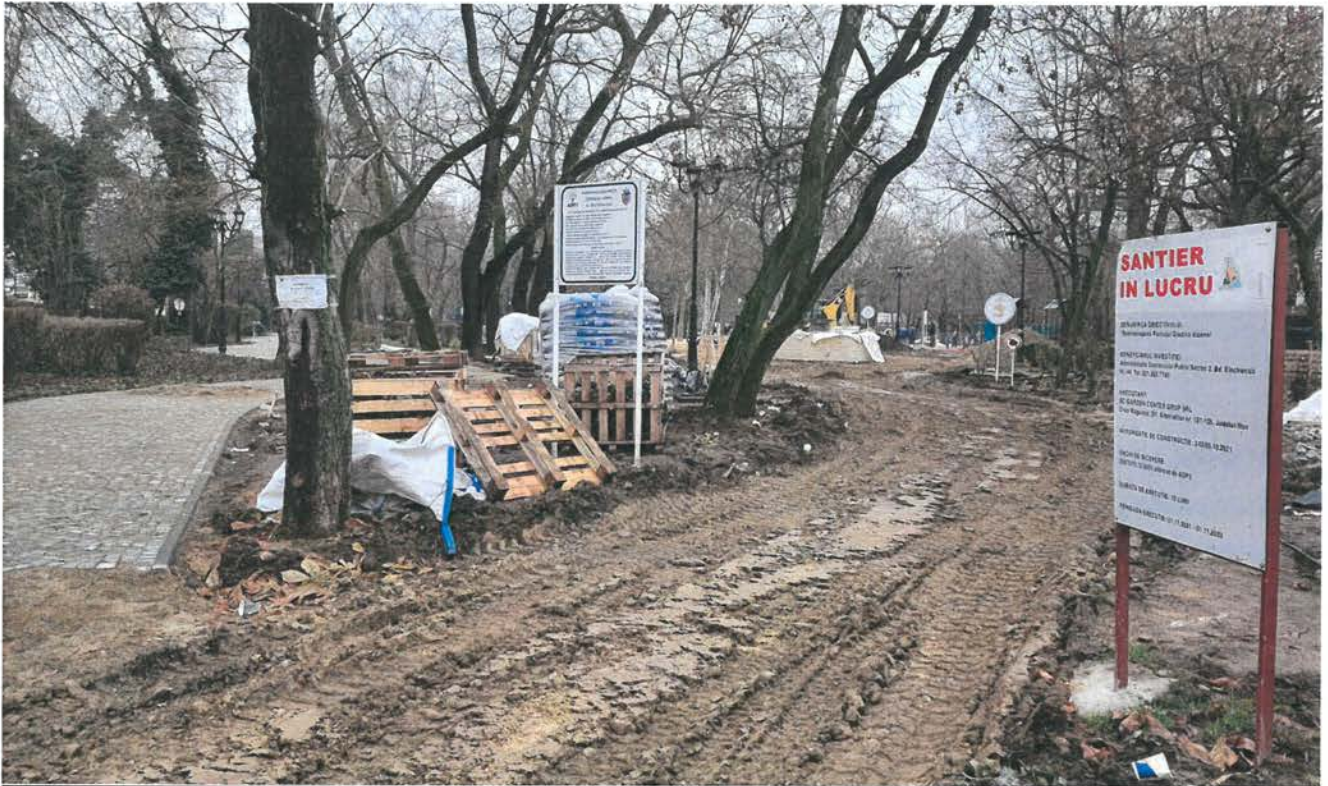
Fig. 2 - Exemplu referitor la tasarea solului prin depozitarea materialelor de construire pe zona unde se află rădăcinile arborilor
