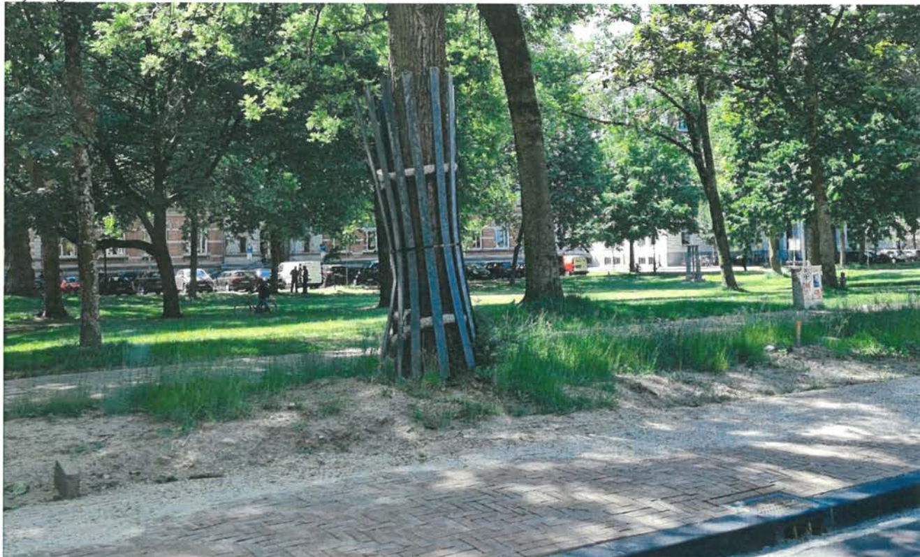
Fig. 8 - Exemplu referitor la protejarea trunchiurilor arborilor existenți pe parcursul realizării unor intervenții de amenajare: platbande metalice aplicate peste odgoane
