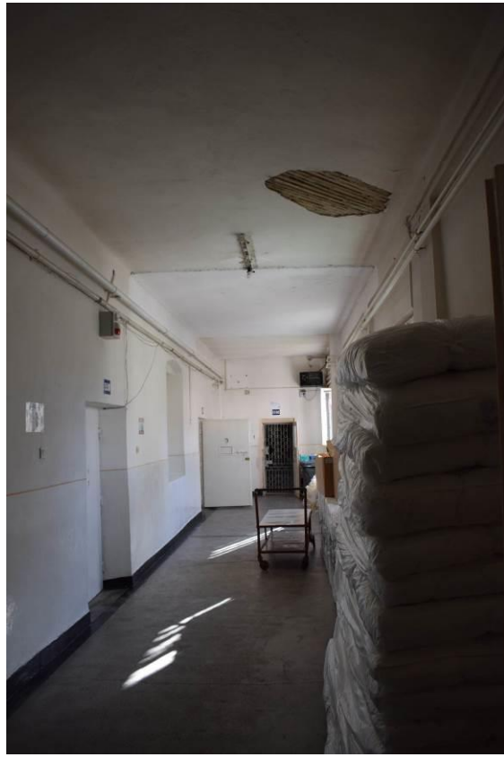
Planseu lemn degradat intre etaj 1 si pod
