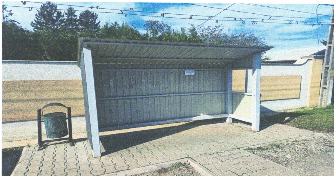
5. Statie Nisip DN1 Ploiești -Valenii de Munte stanga
