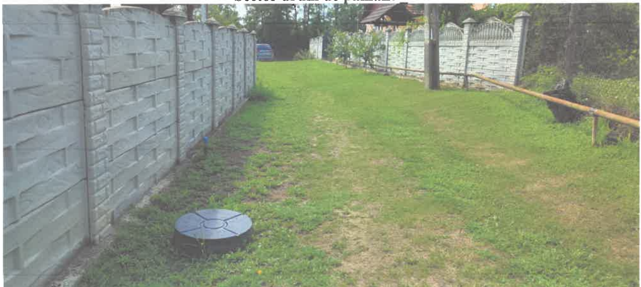
Sector drum de pământ (canalizare pe stg.)
