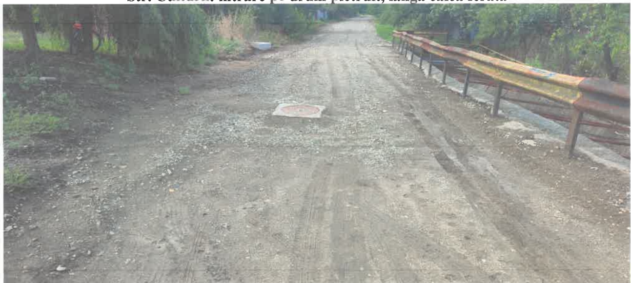
canalizare existent pe carosabil
