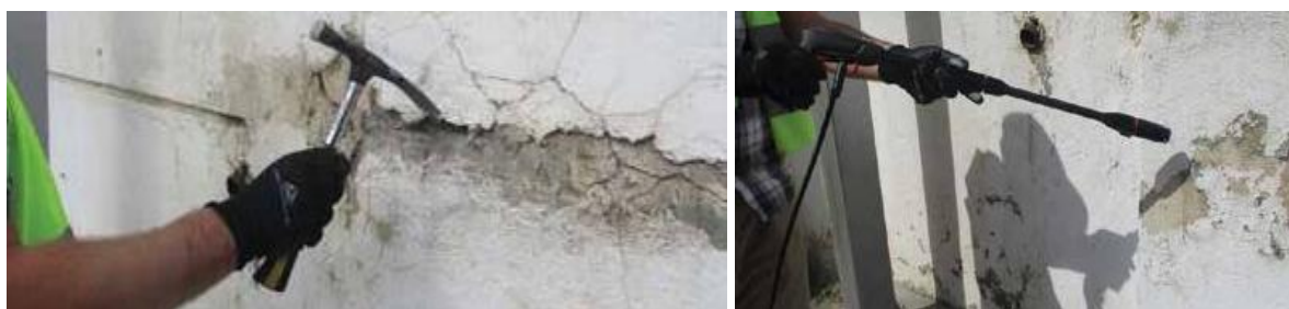
Figura 25 Exemplu curatare pereti exteriori cu tesla si cu un aparat de spalat cu presiune
