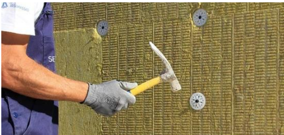
Figura 26 Exemplu dibluire vata minerala dupa lipire
