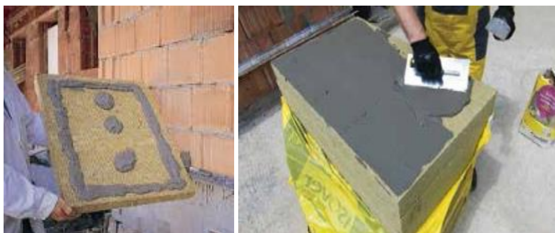
Figura 27 Exemplu de aplicare a adezivului pe vata bazaltică: „în puncte” sau „pe suprafața”
